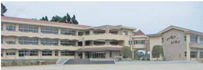
明德小学校の新校舎
